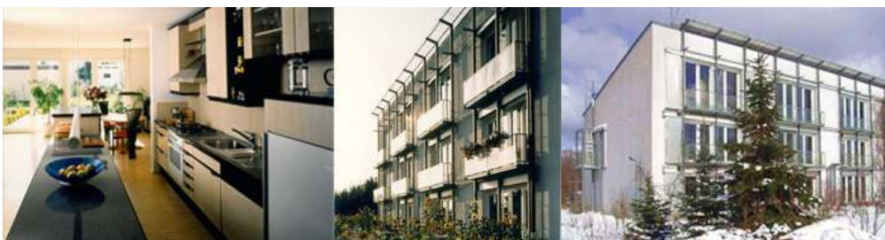
Weltweit erstes Passivhaus in Darmstadt-Kranichstein, 1991
